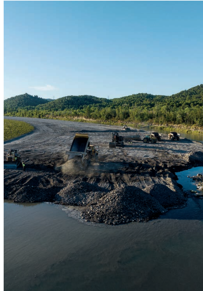
Les travaux de recharge sédimentaire en 2022, menés par le SMAVD, à Charleval (13) et Puyvert (84) avec plus de 100 000 m 3 de matériaux déplacés sur chacun des sites.
